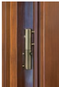
Detail závěsu TRIO a přidavného těsnění
